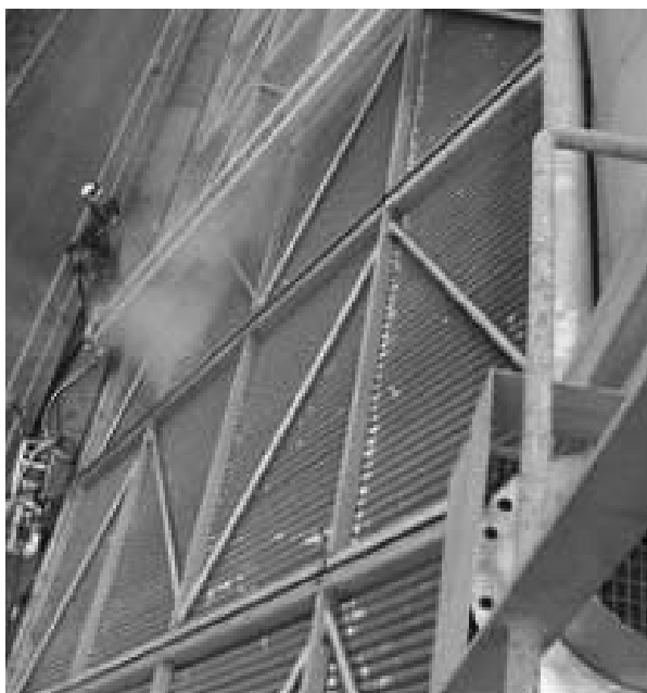
شکل ۵: چالش شستشوی دستی و نیمه اتوماتیک فین تیوب‌های کندانسورهای ACC بوسیله پاشش جت آب
