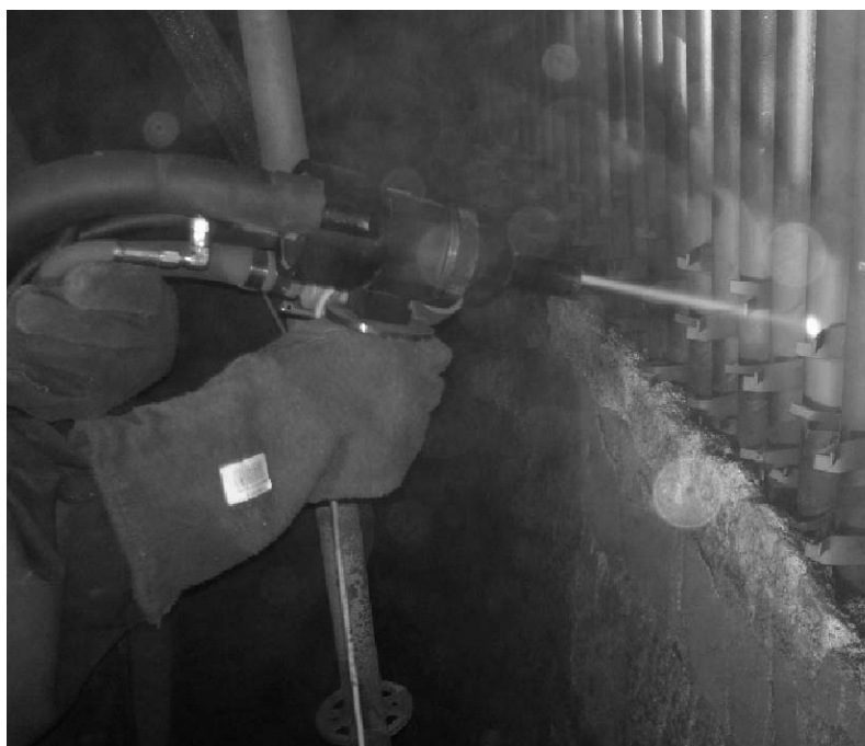
شکل ۴: اعمال پوشش‌های مقاوم به خوردگی بر روی لوله‌های بویلر در محل با روش
