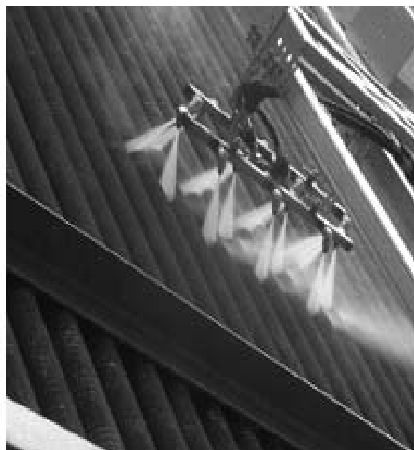
شکل ۵: چالش شستشوی دستی و نیمه اتوماتیک فین تیوب‌های کندانسورهای ACC بوسیله پاشش جت آب
