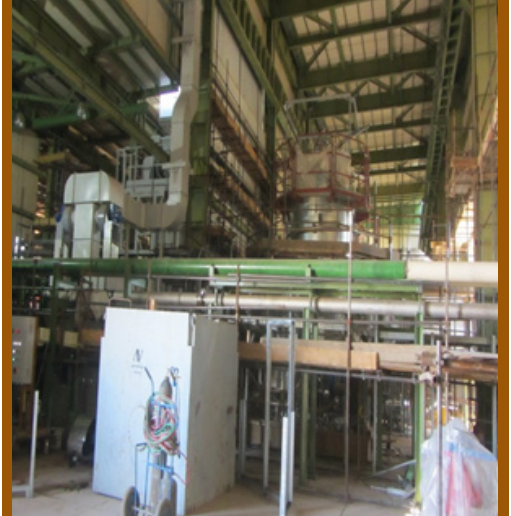
نصب تجهیزات سالن توربین گاز و اجرای عایق چمبر توربین
