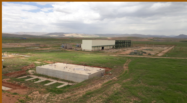
ابتدای سال ۱۳۹۷ نمای کلی از شمال سالن توربین قبل از شروع مجدد عملیات اجرایی
