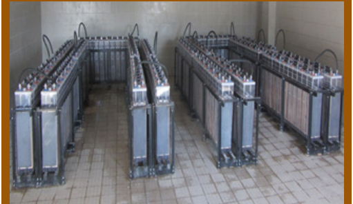
نصب تابلوهای CCB و نصب باتری در باتریخانه CCB
