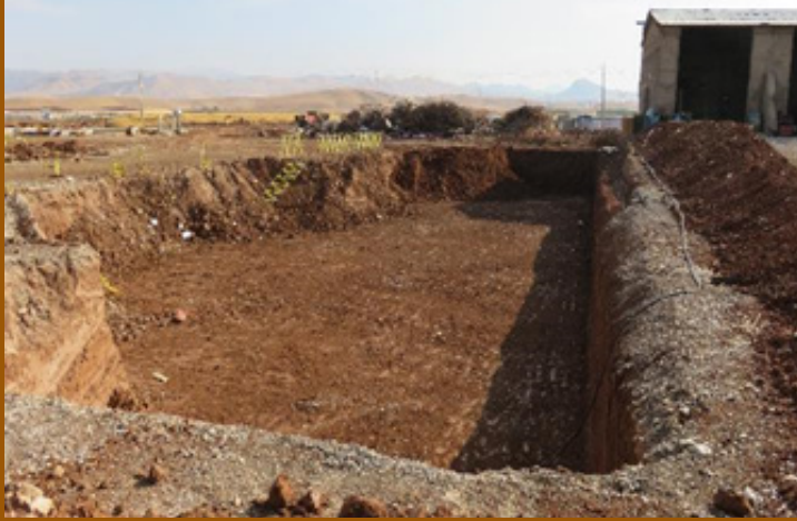
خاکبرداری فونداسیون ACC
